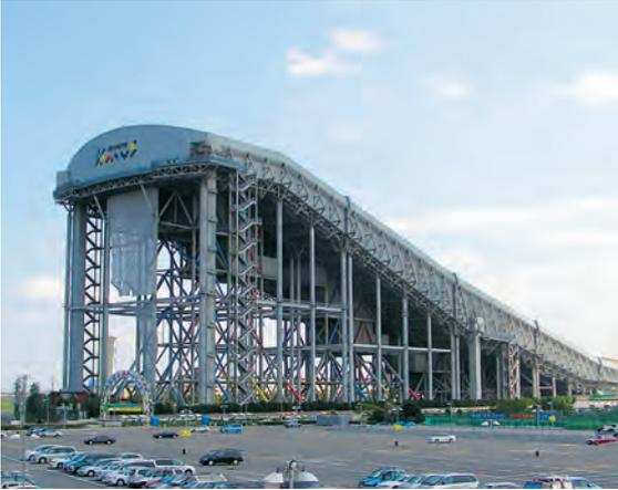
9 Beim SSAWS (Spring-Summer-Autumn-Winter Ski) Skidome Tokyo (1993-2003) wurde die Konstruktion horizontal in fünf untereinander gelenkig verbundene Teile gegliedert, um erdbebenbedingte Spannungen zu reduzieren.
