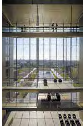
Der Hauptsitz von Thyssen-Krupp in Essen: Das Atrium überspannt eine Brückenkonstruktion mit einer Spannweite von 28 Metern (2010).
