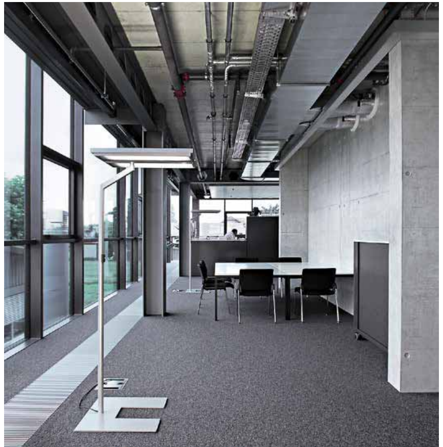
Das einfache Stahlskelett besteht aus durchgehenden HEB-Profilen für die Stützen und Wabenträgern als Hauptträger. Der aussteifende Betonkern dient der Erschliessung.
