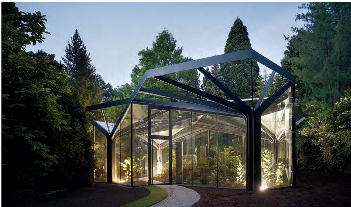
Die aus Flachstahl vorgefertigten Stützen und Träger wurden vor Ort zu einer asymmetrischen Rahmenkonstruktion verschweisst.
