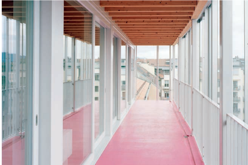
Balcon au niveau de la surélévation.
