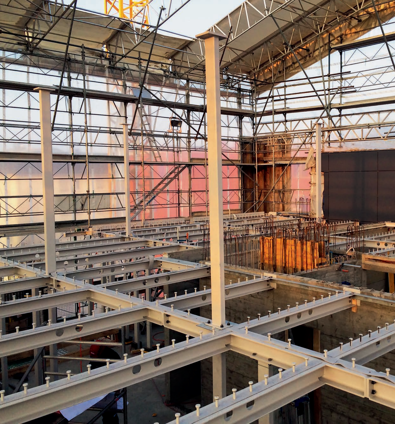
Squelette métallique de l'extension.
