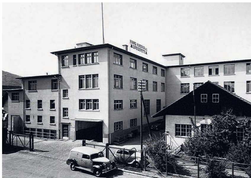
En haut : façade rénoverée de l'ancienne usine et étage en surélévation.
