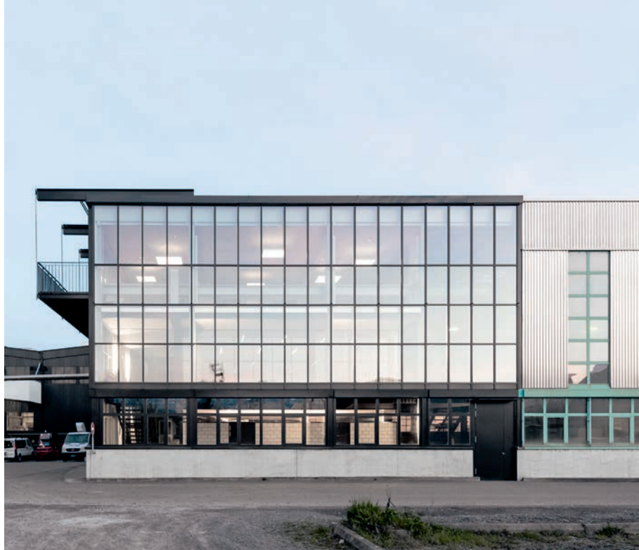
La transformation d'un des angles du bâtiment a bonifié l'aspect de la façade. Transparente, agrémentée d'un balcon, cette façade rideau respecte le rythme du bâtiment existant.
