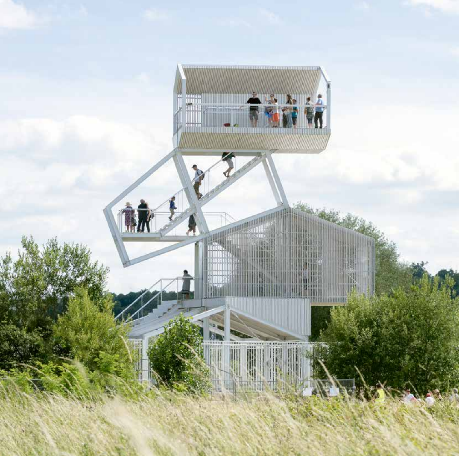
L'Observatoire avec sa structure métallique toute en finesse. Certaines faces sont habillées de lames de bois.
