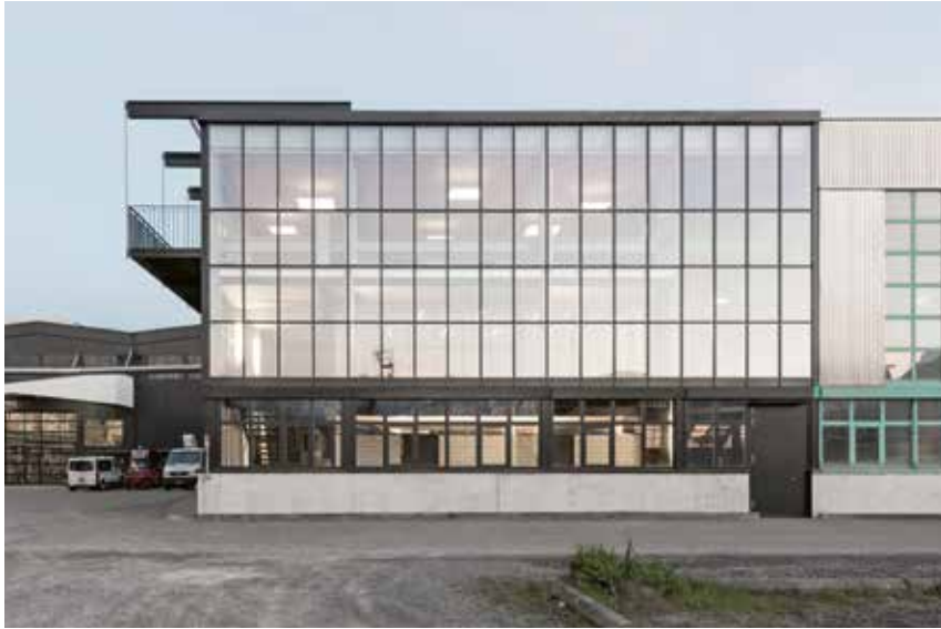
Haut : façade rénovée et surélévation de l'ancien atelier.
