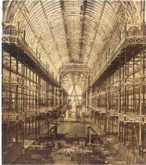
Le Crystal Palace de Sir Joseph Paxton, un bâtiment constitué d'éléments préfabriqués en fonte, érigé en 1851 sur le site de l'exposition universelle de Londres, à Hyde Park, a été démonté en 1854 puis remonté à Sydenham, au sud de Londres (à droite).
