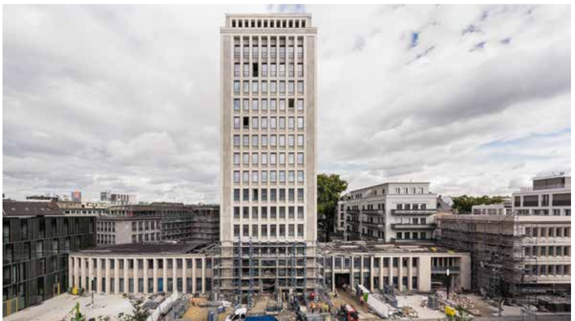
L'immeuble Gerling après réhabilitation.
