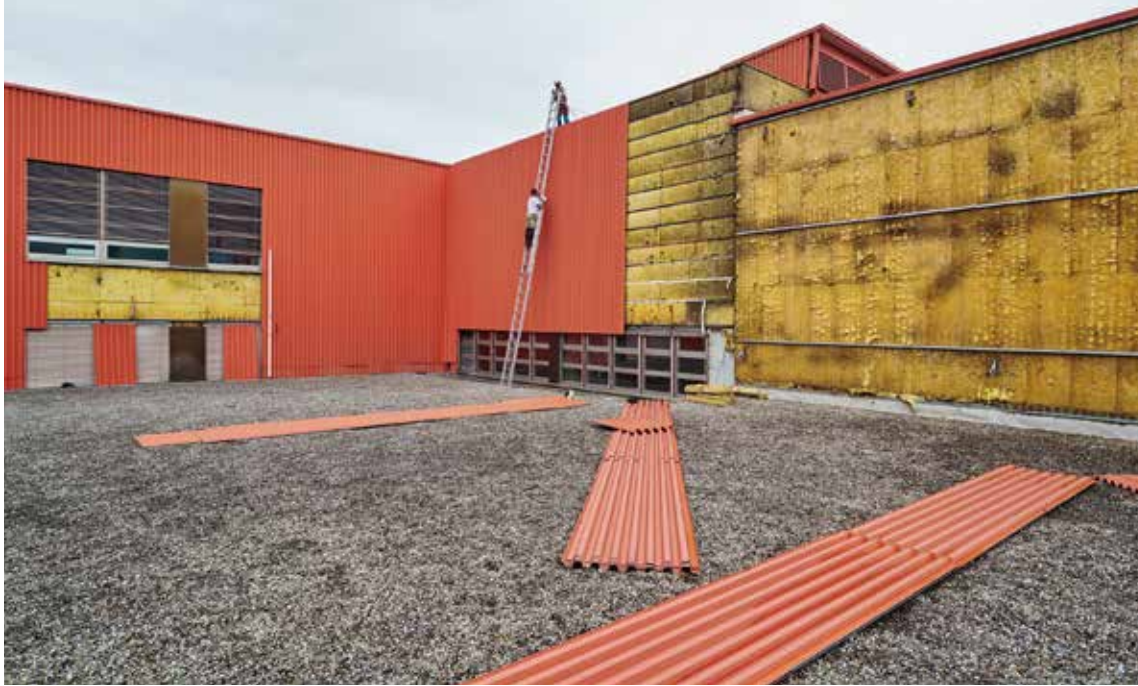
800 m 2 de bardage aluminium sont « récoltés » sur le bâtiment de Zieglerdruck à Winterthour. Utilisés pour les façades de la surélévation, ils s'intégreront parfaitement à la palette colorée du site industriel du Lagerplatz, caractérisée par ses tons rouges.
