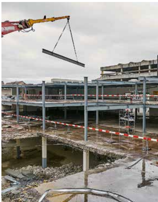
60 tonnes d'IPE et d'HEA proviennent de la charpente de la centrale de distribution Coop de Lysbüchel à Bâle. Elles ont été stockées en attendant leur réemploi à Winterthour.
