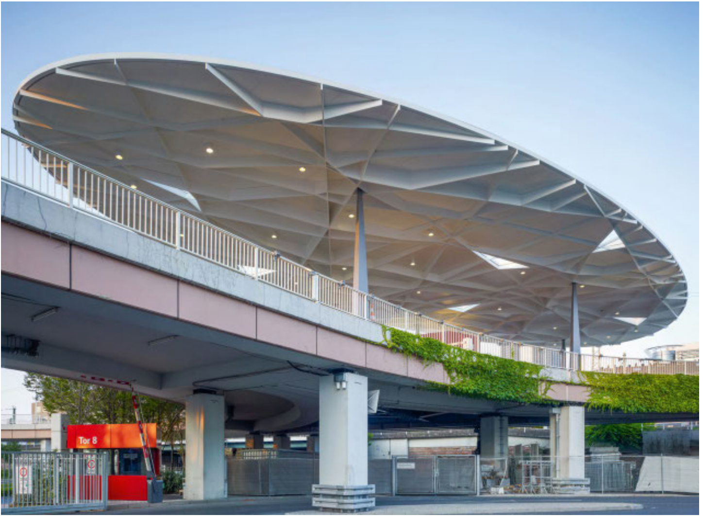
Die unterschiedlich hohen Flachstähle strukturieren die Untersicht der Überdachung.
