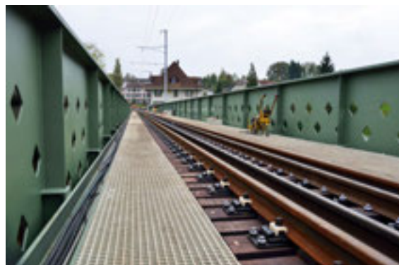
Der Verlauf der rautenförmigen Öffnungen akzentuiert den Kraftfluss im Träger.
