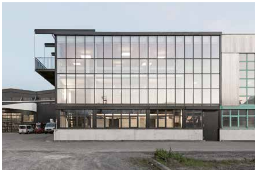
Oben: sanierte Fassade und Aufstockung des früheren Fabrikgebäudes.
