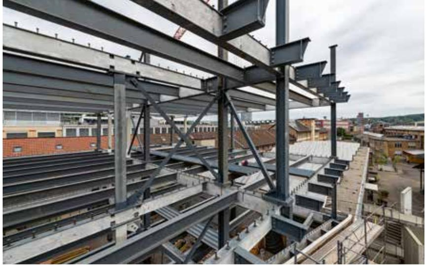
Protection incendie de la surélévation: l'âme des poutres de rive et de certaines poutres secondaires de la surélévation est enrobée de béton et l'effet membrane du plancher mixte s'active en cas d'incendie.
