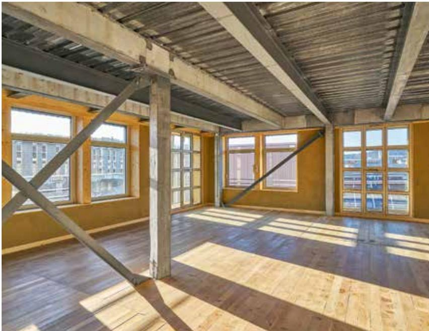
En haut : ateliers dans la surélévation. Les deux étages supérieurs sont en porte-à-faux sur le bâtiment trapézoïdal existant. Trois treillis métalliques contreventés en croix et une nouvelle cage d'ascenseur assurent la rigidité horizontale.
