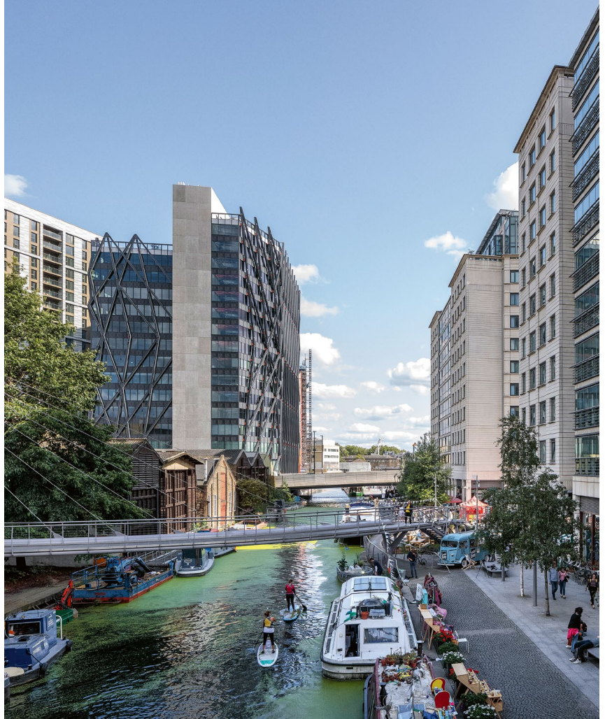
Ansicht des Brunel Building aus Nordwesten über dem Paddington Canal. Der Kanal dient heutzutage praktisch ausschliesslich Freizeitzwecken.
