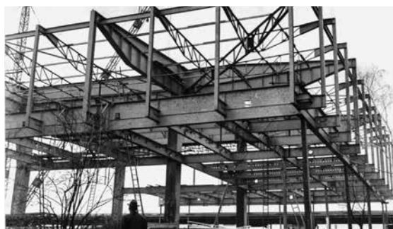
Die Stahlstruktur beim Wiederaufbau in Österreich 1960.
