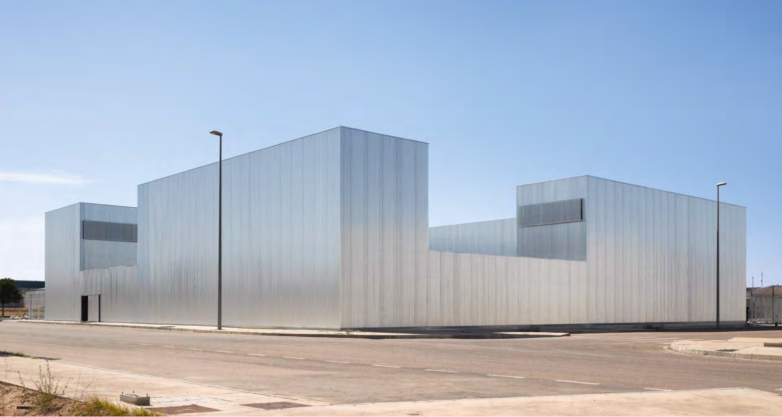
Aussenansicht des Gebäudes von Nordosten.
