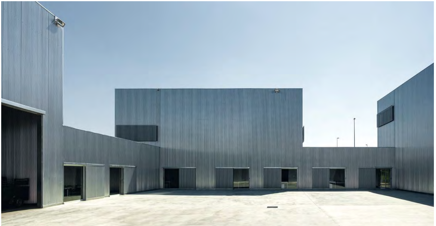
Innenhof: Warenumschlagplatz und Manövriertfläche für Sattelzüge.
