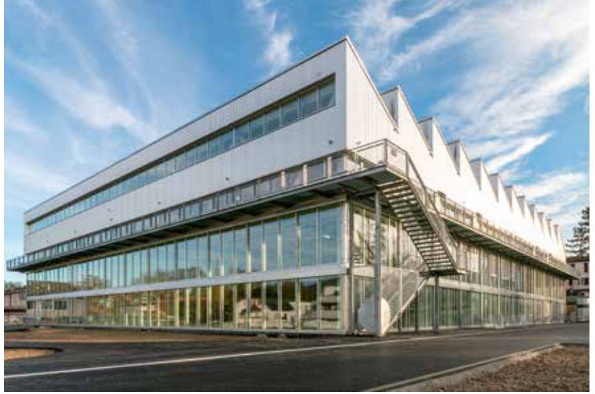
Oben: Die Sekundarschule Laufen von Nordwesten gesehen. Die nach Norden ausgerichteten Lichtbänder der Sheddächer sorgen für eine Atelieratmosphäre in den darunter liegenden Lernlandschaften. Die Sporthalle befindet sich hinter der Glasfassade an der Nordwestecke.
