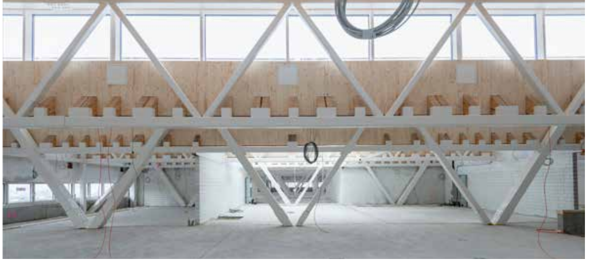
Die kleinen Fachwerkträger (vorn) tragen nur Teile des Dachs, die doppelstöckigen tragen dazu noch die Decke der Sporthalle und der Aula.
