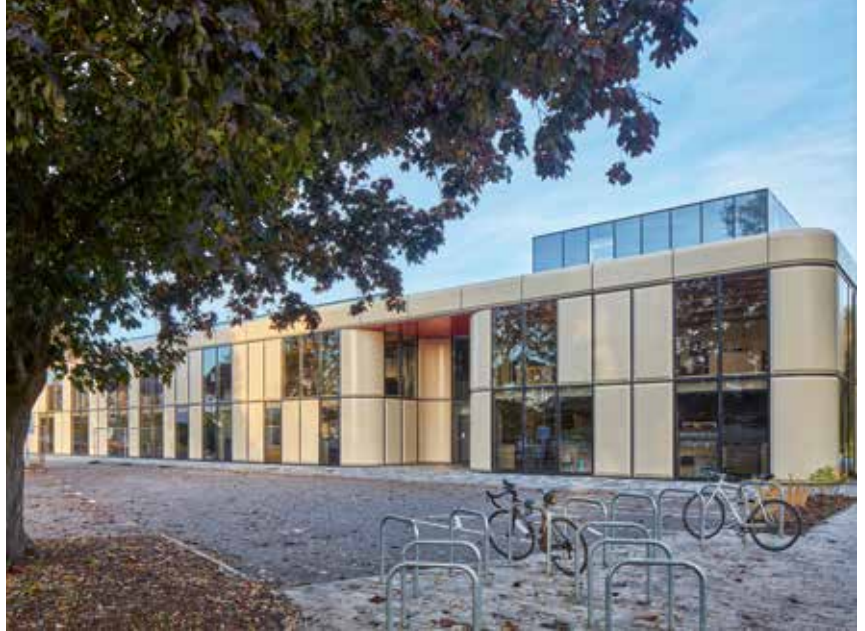
Die Fassade mit ihren modularen Paneelen wurde für die Umnutzung ertüchtigt.
