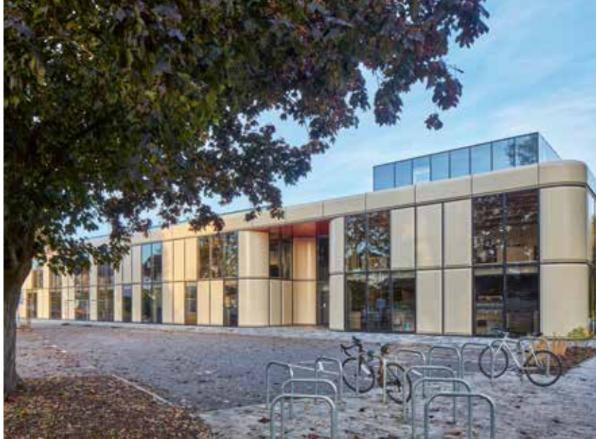
La façade à panneaux modulaires a été modernisée pour ce changement d'usage.
