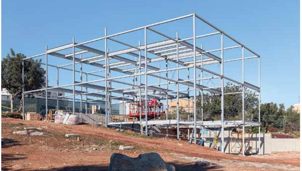
Das 11,25 m breite und 18,75 m tiefe Grundskellett basiert auf der Addition eines dreidimensionalen Grundmoduls, das im Grundriss 3,75 x 3,75 m und in der Höhe 3,16 m misst. Die Aussteifung übernehmen Stahlverbände, die in den Leichtbauwänden verborgen werden.
