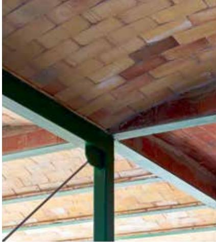
Das Prinzip der Kappendecke ins 21. Jahrhundert transferiert: Das «Brick Vault House» bei Valencia (ES) ist räumlich geprägt von der Kombination eines Stahlskeletts mit auf den Trägern liegenden, flachen Ziegelgewölben.
