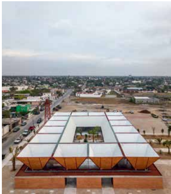
Aus der Luft betrachtet ist der Aufbau der Markthalle ablesbar: 16 kleine Trichter sind um einen mittigen, grösseren angeordnet, der den kleinen Garten des Markts rahmt.
