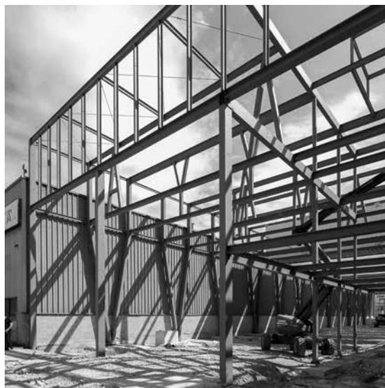
La structure en acier vient se placer devant les murs extérieurs existants des bâtiments avoisinants et les espaces intermédiaires sont comblés par une maçonnerie en parpaing ou des plaques de plâtre ignifugées. Le dernier étage de la structure frontale se compose de poutres Vierendeel.
