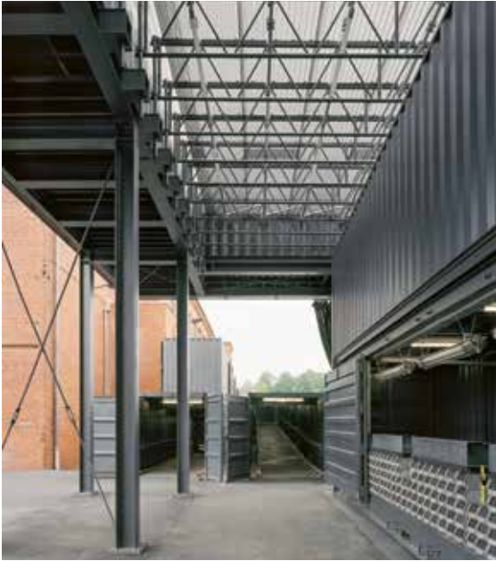
Oben links: Die Mittelzone des Dachs ist aus Gerüsttraversen gefertigt.
