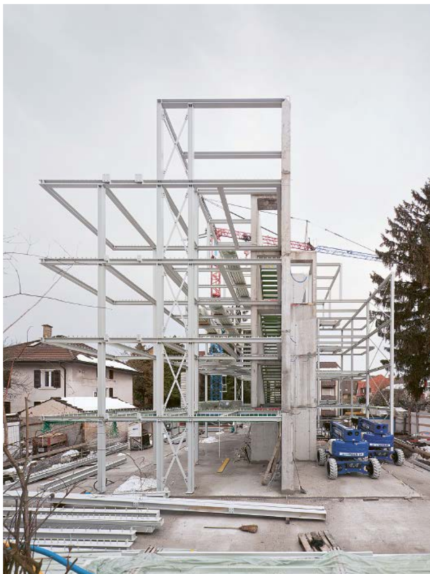
Unten: Eine Brandwand aus Ort beton teilt das Gebäude auf der Parzellengrenze in zwei Einheiten.
