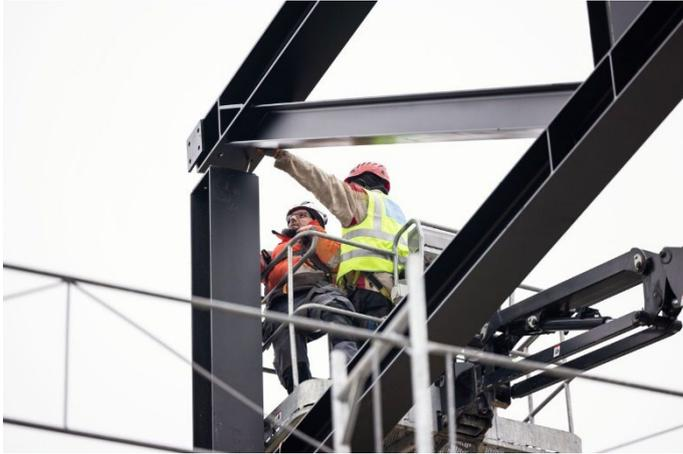
*In 14 Meter Höhe sind die Fachwerke mittels zweier Hebebühnen montiert worden. Weiterer Text über ots und [www.presseportal.ch/de/nr/100053189](http://www.presseportal.ch/de/nr/100053189)*
