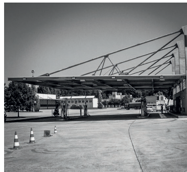
Photos AEPLI STAHLBAU AG GOSSAU
