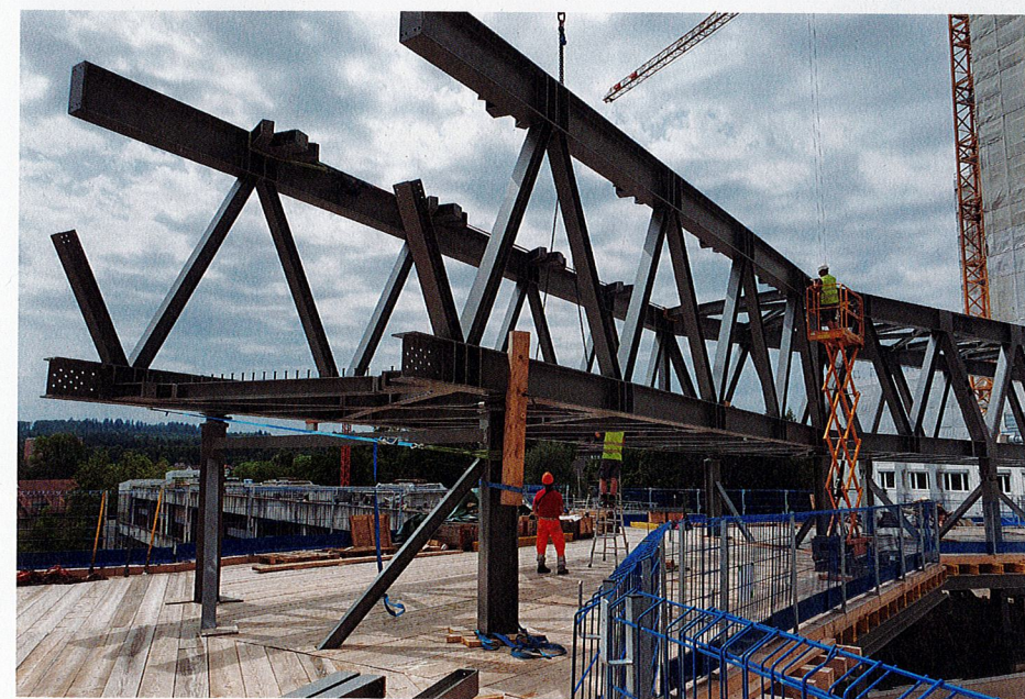
Die Montage der Passerelle erforderte höchste Präzision. Die Einzelteile wurden im Werk vormontiert, in transportfähigen Fachwerkabschnitten angeliefert und auf der Baustelle zusammengefügt.
