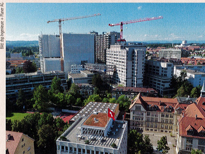
Baustellenansicht des neuen Hauptgebäudes des Inselspitals mit der Passerelle zur Kinderklinik.
