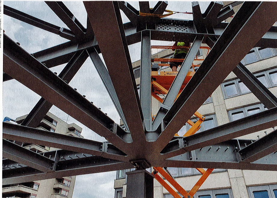
Die Fachwerkkonstruktion weist an den Anschlusspunkten «mit Knick» komplizierte Knotenpunkte auf, hier der sogenannte Weihnachtsstern mit zehn Stäben.
