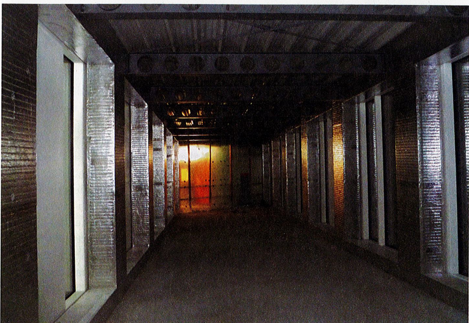
Eine der drei Passerellen vom neuen Hauptgebäude zum INO. Sie waren bereits im Juli fertig montiert und mussten zum Besichtigungszeitpunkt noch ausgebaut werden.
