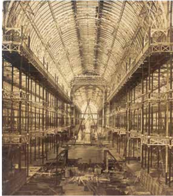
Le Crystal Palace de Sir Joseph Paxton, un bâtiment constitué d'éléments préfabriqués en fonte, érigé en 1851 sur le site de l'exposition universelle de Londres, à Hyde Park, a été démonté en 1854 puis remonté à Sydenham, au sud de Londres (à droite).
